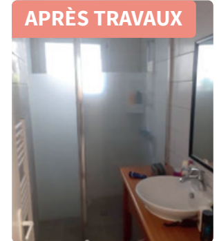
Réfection de la salle de bain.
