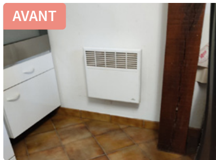
Le radiateur a été changé, la puissance n'était pas adaptée à la dimension de la pièce.
