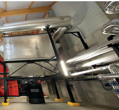
Chaufferie biomasse de la CUA
