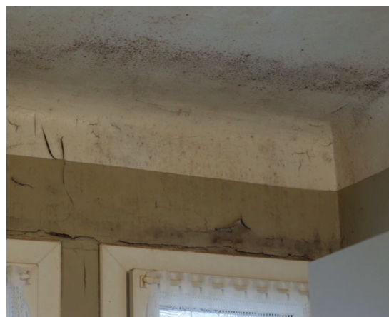
Image : dégradations liées à l'humidité et la mauvaise isolation, Ganges. Crédits : Bertrand Sinssaine
