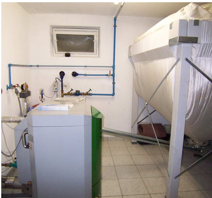
Chaudière à granulés de bois et son silo
