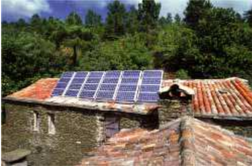
Maison rurale isolée dans le Gard équipée de modules photovoltaïques
