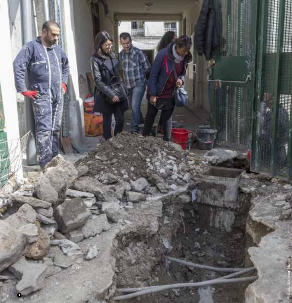
❶ Dans cet immeuble de l'avenue Wilson, à Saint-Denis, le syndicat de redressement supervise les travaux sur une canalisation destinée aux eaux usées.
