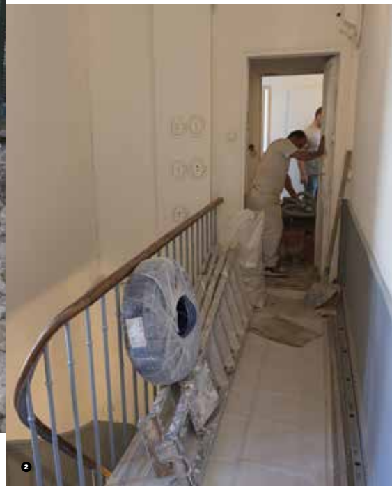
❷ Parties communes en cours de réfection dans un immeuble situé à Saint-Denis.
