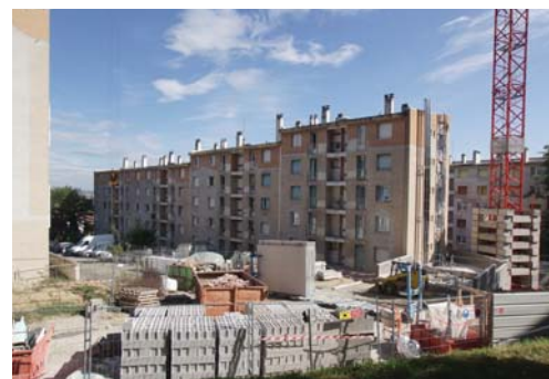
Sciage des balcons
