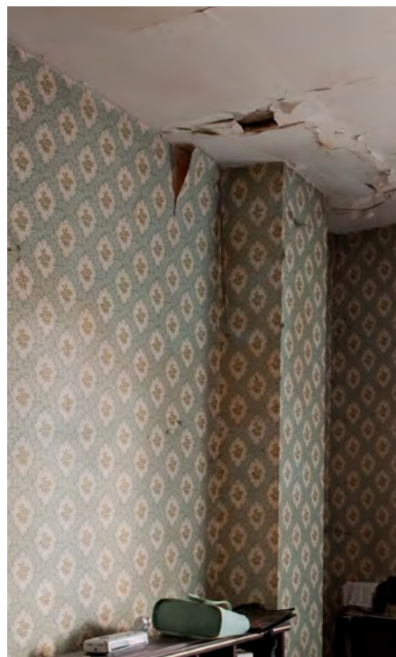
Le programme Habiter Mieux permet d’intervenir spécifiquement sur la performance thermique des logements.
