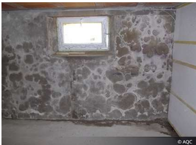
Figure 12 - Développement de micro-organismes suite à l'installation d'une menuiserie neuve dans une cave non ventilée ». (Source : Malette pédagogique, AQC)
